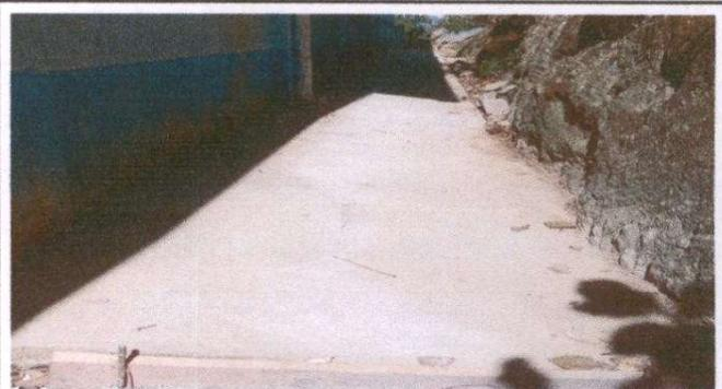
Foto 8: Reparación de banquetas en concreto
